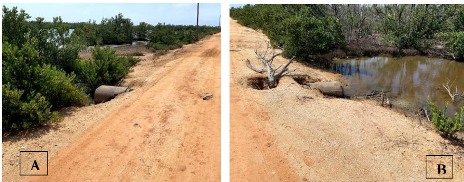
Figura 9. Vial de acceso reconstruido, donde se expone la situación del único paso de agua para conectar el escurrimiento de sector W (A), con el del E (B). Fotos. Yosviel González Rodríguez
