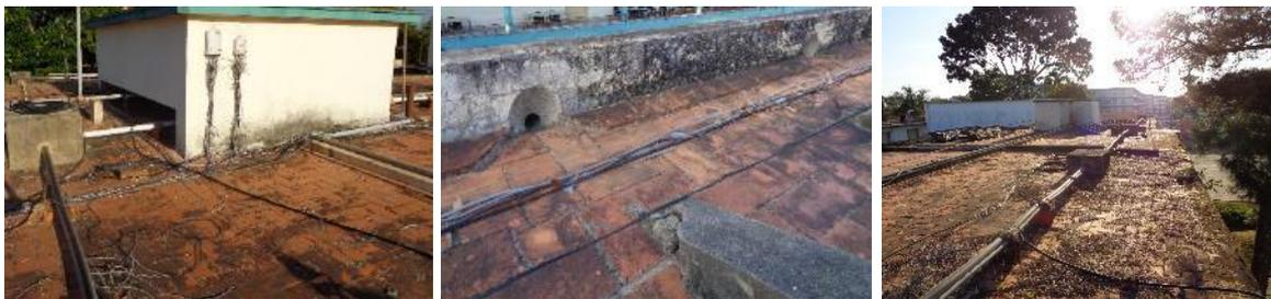
**Figura 2.** Cubierta del edificio de la rectoría. Disposición no adecuada de redes de electricidad, abasto de agua y comunicaciones. **Fuente:** Elaborado por los autores.
