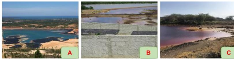
**Figura 4.** Pasivo ambiental químico (PAQ) en la región de Santa Lucía. (A)-Presa de las colas del proceso de flotación de plomo y zinc, (B)-Nichos con desechos peligrosos en la zona costera, (C)-Aguas ácidas confinadas en la zona costera por el talud producto al lavado de las cenizas tostadas. Fuente: Bruguera, Gallardo y Díaz, 2020
