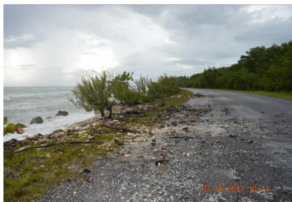
Figura 2. Acumulación de rocas, sedimentos y arena en un sitio en el vial de La Bajada a María la Gorda. Foto: Lázaro Márquez LLauger
