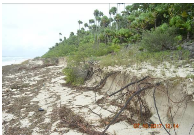
Figura 7. Desplazamiento del talud existente en la playa Caleta Larga hacia la franja de vegetación costera. Foto. Lázaro Márquez Llauger
